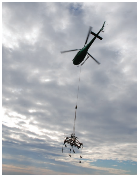
Eliminació d'una línia elèctrica. Font: CPNSC
