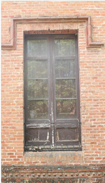
Foto Finestra v.19 N exterior
