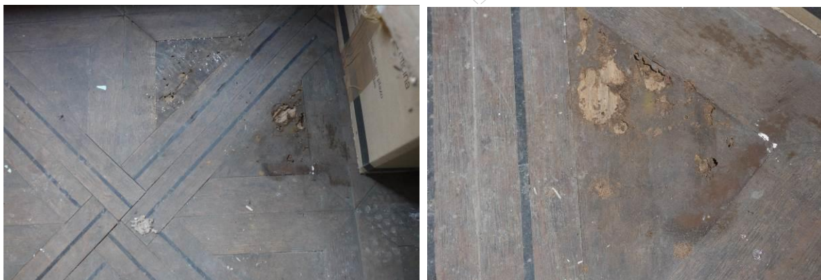
F-24 i 25 Imatge dels tèrmits del paviment de la planta baixa.
