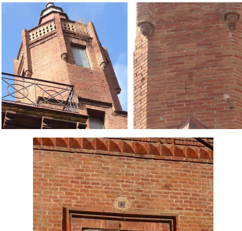
F-26, 27 i 28 Imatges de les petites esquerdes de les diferents façanes.
