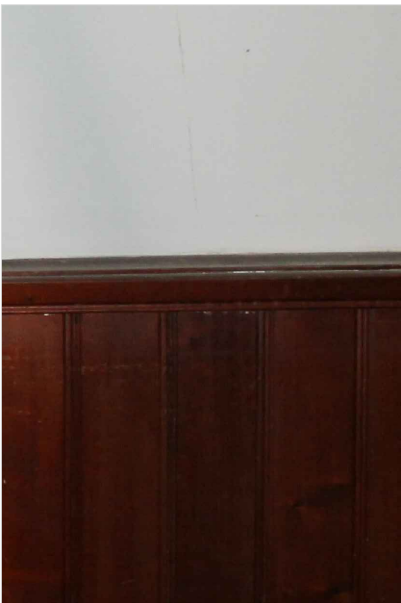
Foto revestiment amb fusta fosca - arrembador fusta lames verticals
