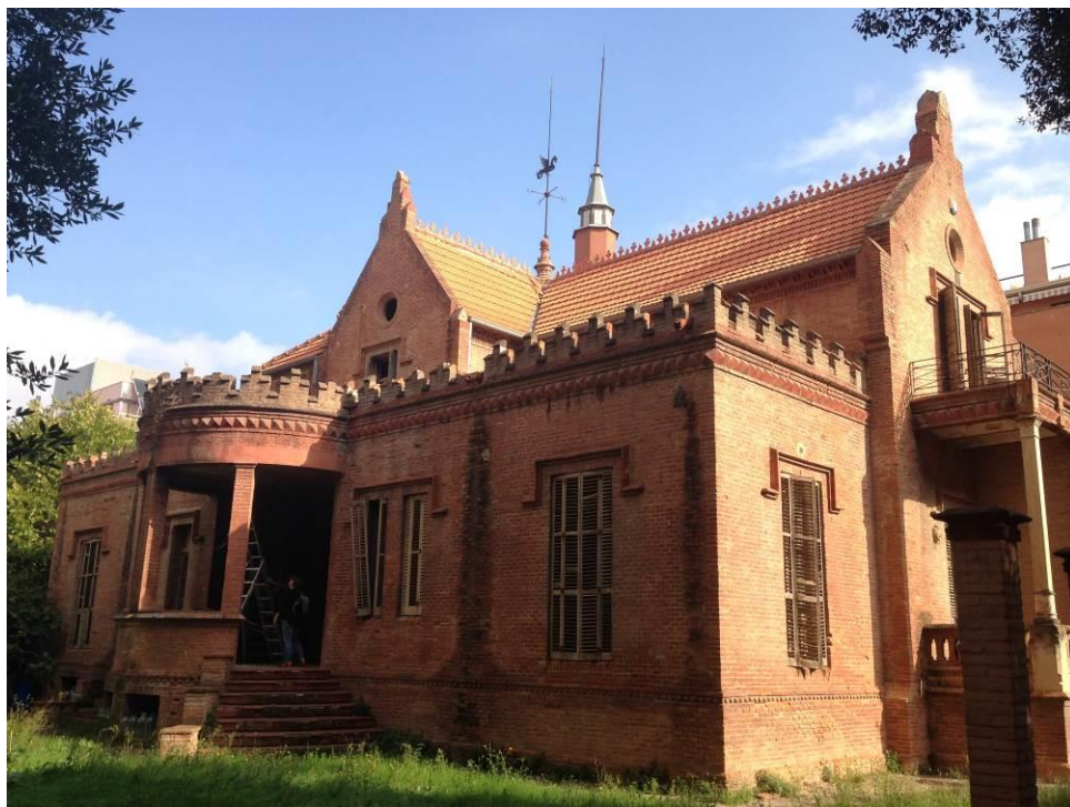
F-1 Imatge de l'exterior de l'edifici – Cantonada façanes sud-oest
