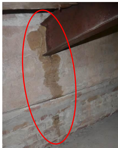
F-17 Imatge de l'entrada d'aigua per un dels aiguafons de la coberta.
