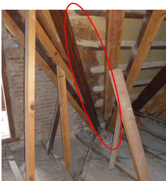
F-17 Imatge de l'entrada d'aigua per un dels aiguafons de la coberta.
