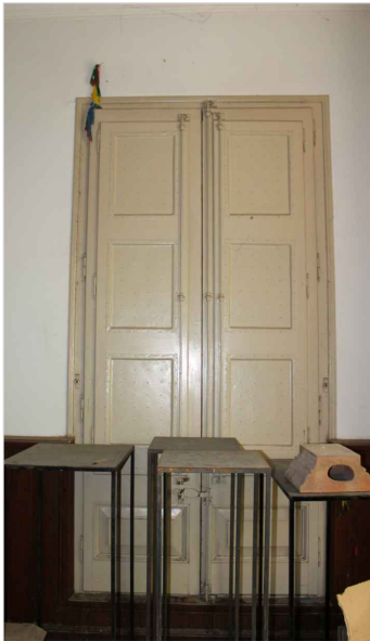
Foto Finestra v.19 N interior
