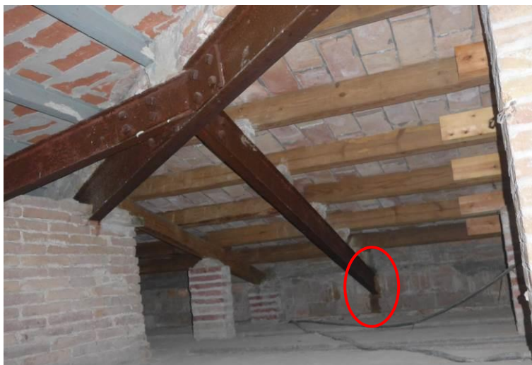
F-17 Imatge de l'entrada d'aigua per un dels aiguafons de la coberta.
